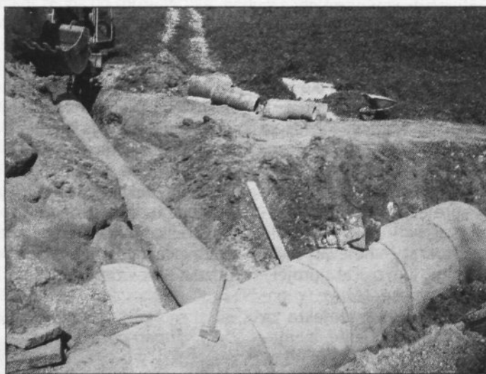
STRANJE-ZGORNJA BLANCA - V skladu s prvim delnim sanacijskim programom za popravilo škode po neurju v tem času potekajo dela na cesti Stranje-Zgornja Blanca, kjer Občina Krško urejuje odvodnjavanje in čiščenje obtočnih prepustov. Ob cesti bo izdelan tudi manjši podporni zid, urejeno bo tudi obstoječe cestišče. Vrednost naložbe znaša približno 6 mio tolarjev.
