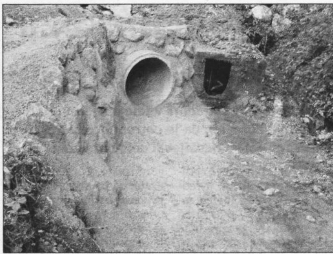
STOLOVNIK-ILOVEC - V zaključni fazi so tudi dela na odcepu Stolovnik-Ilovec v KS Brestanica. Saniran je del rečne struge, ki jo je poškodovano lansko neurje, in urejeno odvodnjavanje, ki je botrovalo uničenju celotnega cestišča. Trenutno potekajo zaključna dela na cestišču, ki bo dobilo tudi novo asfaltno prevleko. Predračunska vrednost omenjenih del znaša dobrih 13 mio tolarjev.
