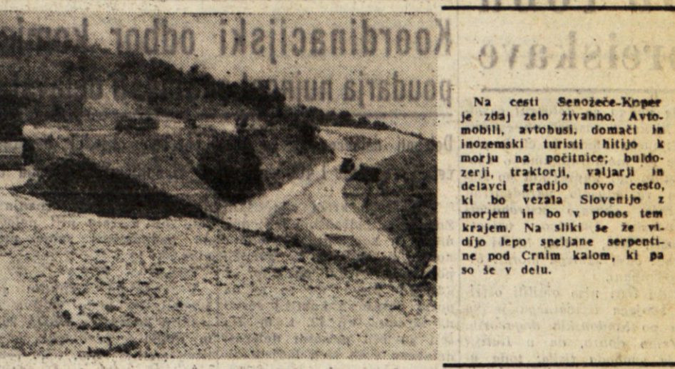
Na česti Senožce-Koper je zdaj zelo živahno. Avtomobil, avtobus, domači in inozemski turisti hitijo k morju na počitnice; buldozerji, traktorji, valjarji in delavci gradijo novo cesto, ki bo vezala Slovenijo z morjem in bo v poos tem krajem. Na sliki se za vidi lipo spjelane serpentine pod Crnim kalom, ki pa so se v delu.
