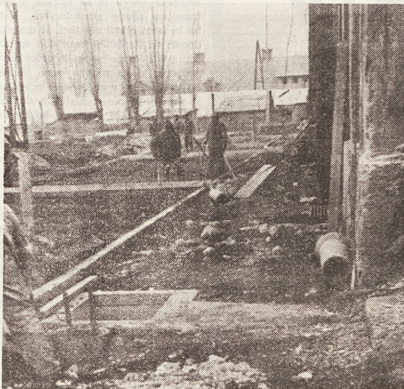
V tovarni dušika v Rušah gradimo poleg adaptacij in dozidav tudi pripadajoči kos ceste in kanalizacije
