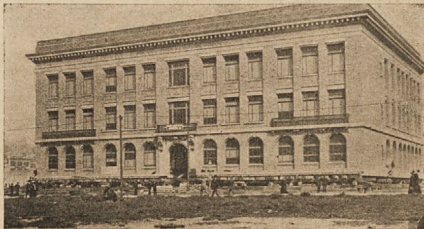
Spretnost ameriških inženirjev: Šolsko poslopje, ki so ga odločili od temeljev in ga prepeljali na drugi konec mesta, da postavijo na prejšnjem kraju — novo občinsko hišo.
