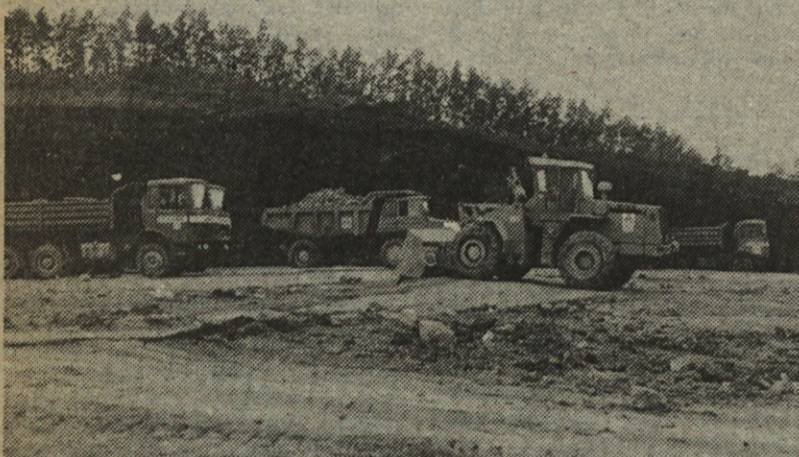
Brez težke gradbene mehanizacije pri zemeljskih delih ne gre
