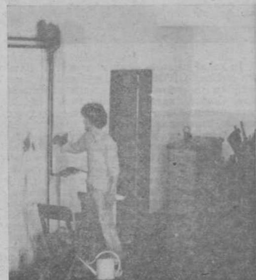
Obnovitvena dela v domu kulture Smlednik
