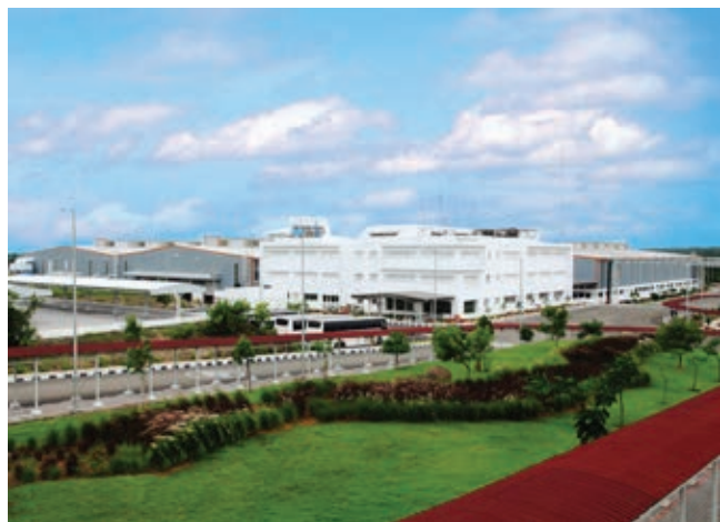
» Air Centre Plant (ACP) je najsodobnejši proizvodni obrat podjetja ELGi v Indiji, obsega 32.700 kvadratnih metrov proizvodnih površin in se razprostira po 89.000 kvadratnih metrov velikem zemljišču. | Vir: ELGi Equipments
