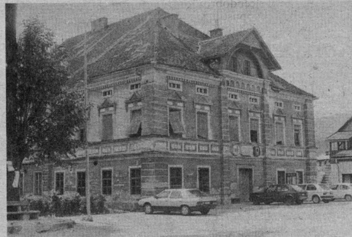
Propadajoča zgradba v Nazarjah kliče po prenovi
