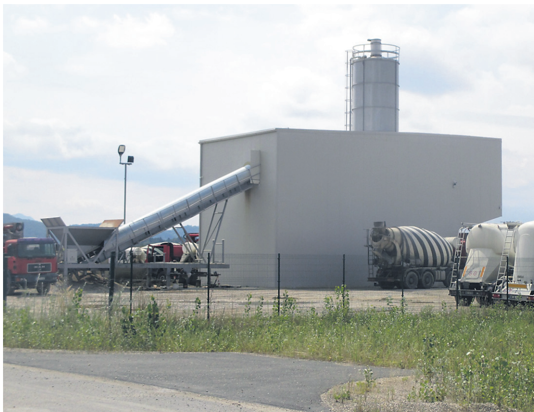
V podjetju Žiher trdijo, da imajo za obratovanje premične betonarne vsa potrebna dovoljenja, na direkciji vodno soglasje.
