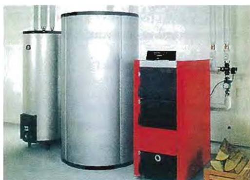
Kotel na polena, hranilnik toplote in boiler za segrevanje sanitarne vode (foto: proizvajalec FRÖLING)
