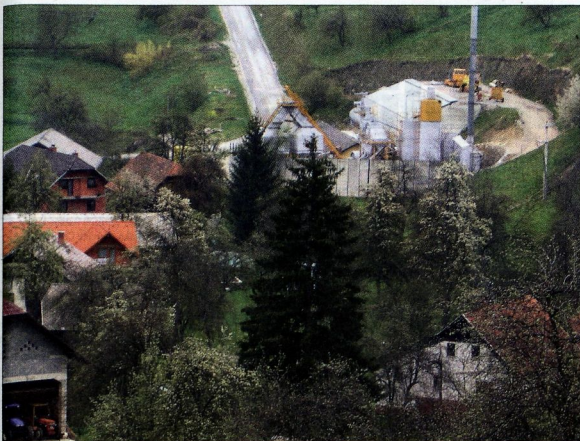
Pogled na asfaltno bazo v Planinski vasi
