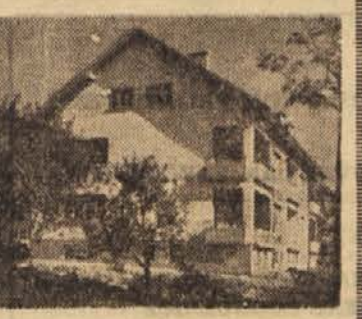
Take stanovanjske hiše, ki jih je zgradilo Gradbeno podjetje Dravograd, lepšajo lice Dravograda
