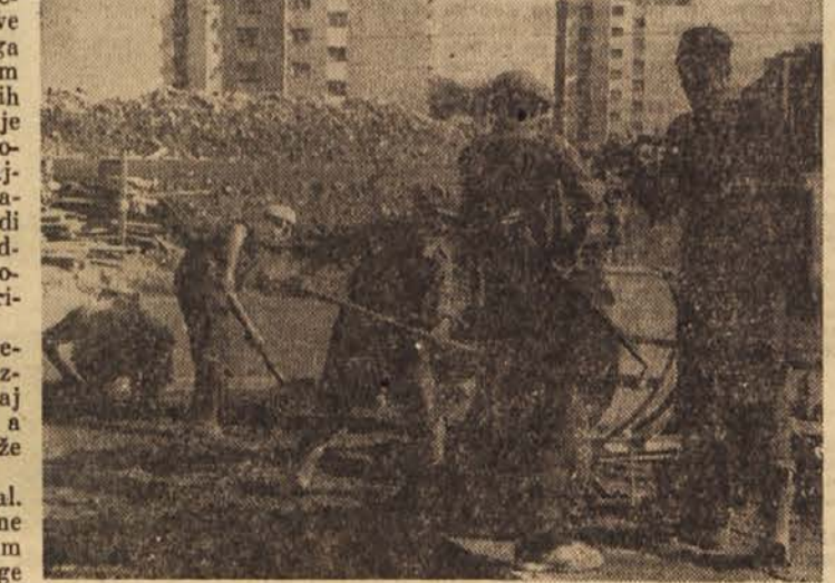
Delavci »Gradbenega podjetja Dravograd« na gradbišču v Mariboru
