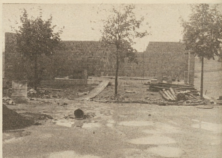
Nova poslovna stavba gradi pri BOLKU krajevna skupnost Hrenovice v sodelovanju s tozdom IZBIRA Postojna. V pritličje se bo preselila dosedanja trgovina. (Foto Paternost)
