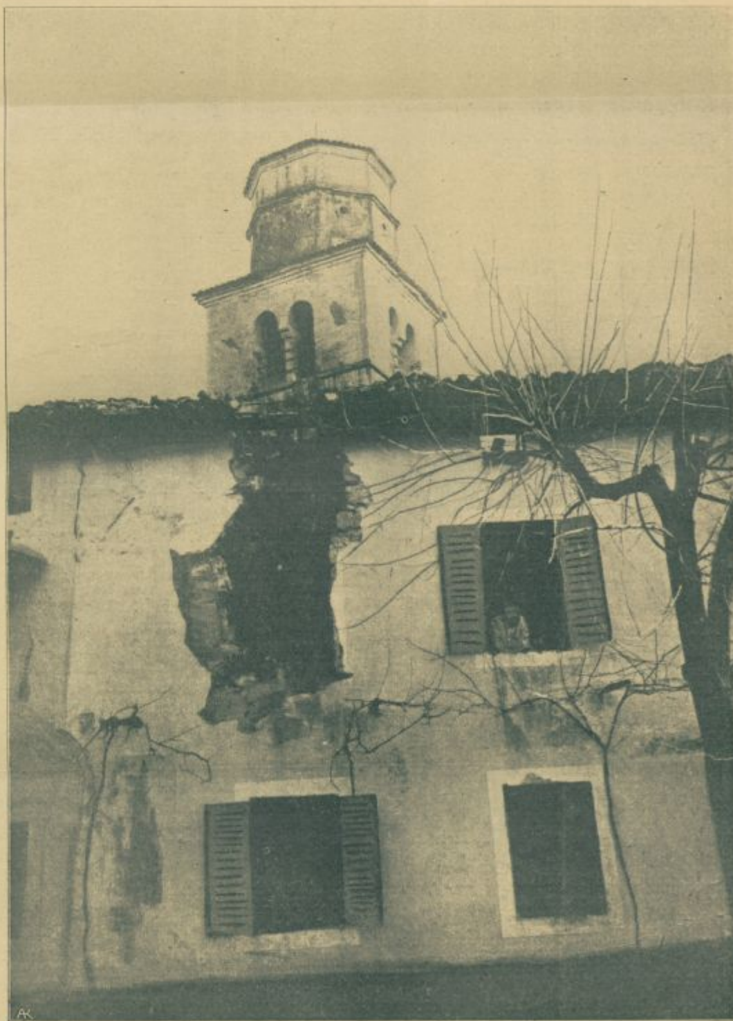
Goriško: Poškodovana cerkev in hiša v Mirnu.
