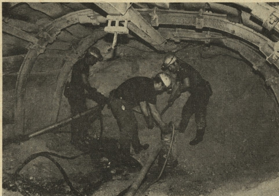
Rudarji pri delu na vpadniku s kote 150 na koto 140 v polju Terezija II.
