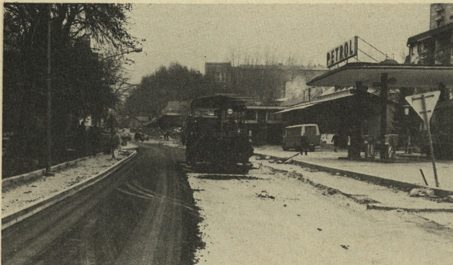
Temeljita obnova glavne ceste v Trbovljah se je zelo zavlekla. Del ceste so asfaltirali sredi novembra, na drugi polovici ceste pa dela izvajajo še naprej. (Foto: B. Klančar)
