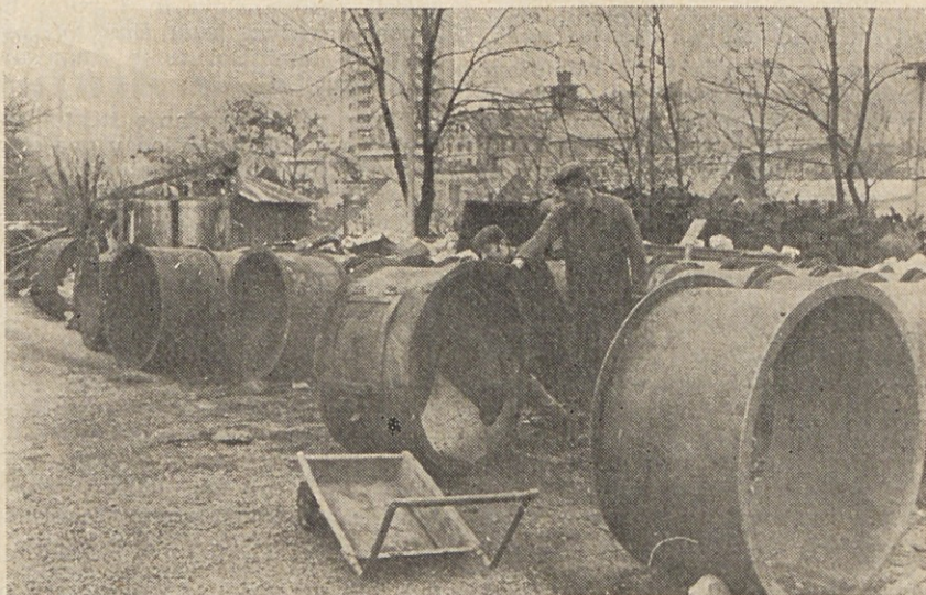
Demontaža starih zavojnih drč pred rudniško delavnico v Hrastniku Foto inž. Tone Bregant
