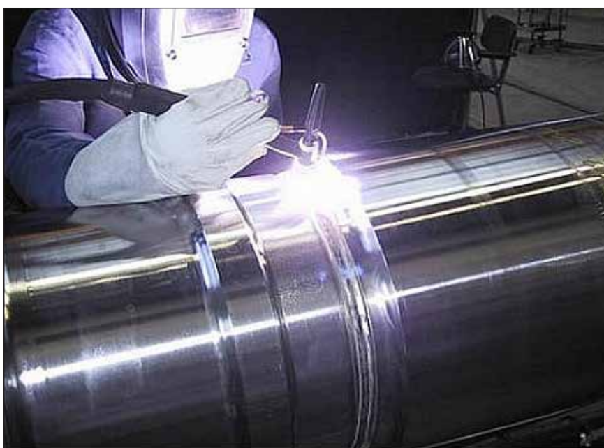
Slika 1. Ročno varjenje cevovodov in drugih varjenih konstrukcij na terenu še vedno pogosto
