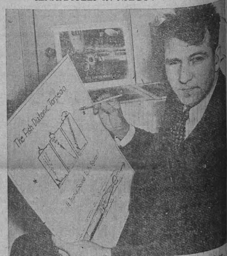
J. Robert Fish, znani iznajditelj iz Springfielda, Mass., svojimi načrti za "diatonski torped", ki se pogrezne na dno morja, kjer se postavi pokonci. Prijateljske ladje plovejo lahko nad njim, ker imajo tajno napravo, katera ne vznemiri torpeda, čim pa pripluje nad torpedo ladja, ki nima te naprave, se torped dvigne ter zadene ladjo.
