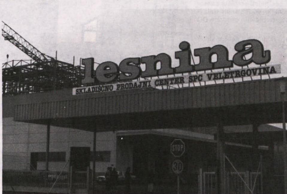
Skladiščno prodajni center Lesnina, prikazan še v gradnji. Foto: Majda Toplak
