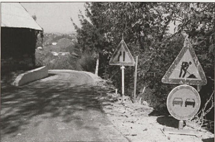
Dela na cesti še potekajo ...
