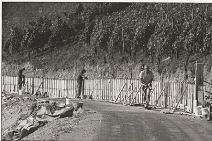
Na območju, kjer cesta pelje v sosednjo občino Videm, smo gradbenike zmotili pri izgradnji še enega podpornega zidu.
