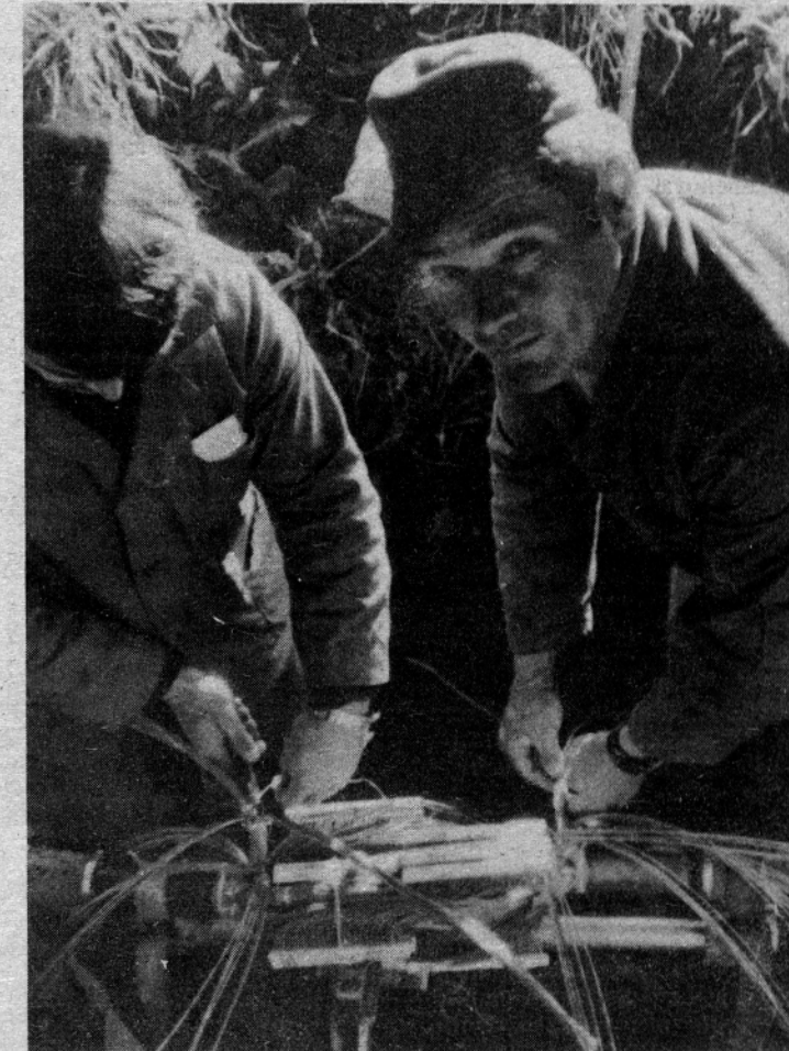
Delavca PAP-a pri vezavi kablov v Nazarjah
