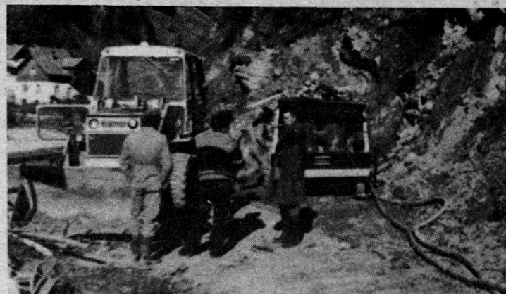
Le težka se prebijajo stroji na odseku, kjer bo priključek ceste proti Črni
