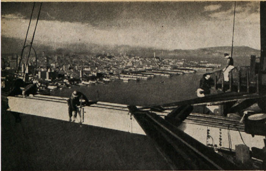
Veliki žerjav na 150 metrov visokem stolpu, s katerim so dvigali jeklene tramove, so morali poprej podpreti s takimi stranskimi podporniki
