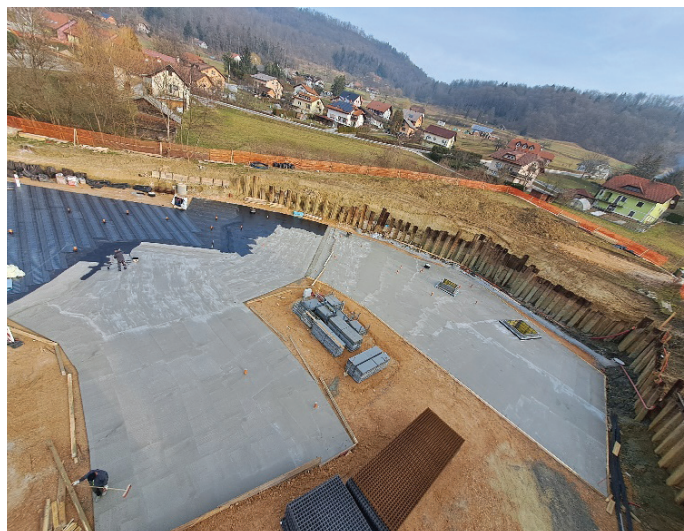
Slika 3. Polaganje hidroizolacije na temeljno ploščo.
