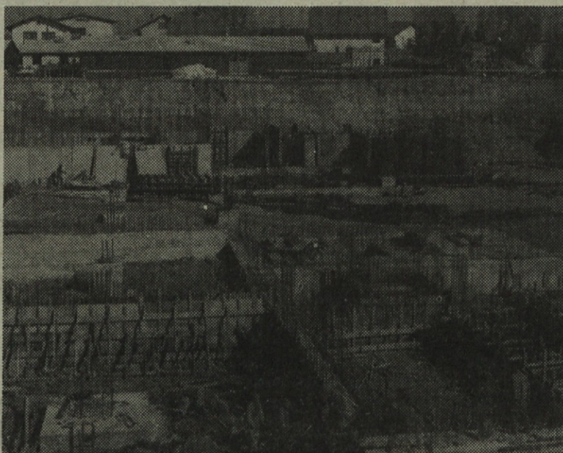
Betoniranje druge kleti za Tehnični center Ljubljanske banke
