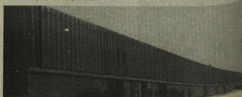
Hala za Javna skladišča v Celju je dolga 240 m in široka 60 m
