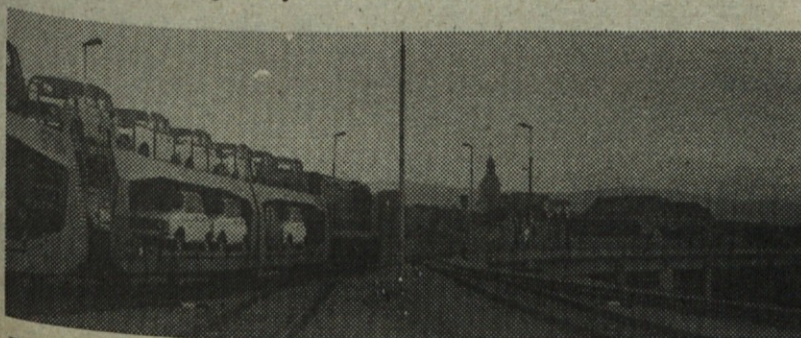
Po železnici bodo proizvodi IMV ceneje in hitreje potovali do kupcev. Temu smo pripomogli tudi gradisovci, saj smo izredno hitro zgradili 560 m dolg most za železniški tir
