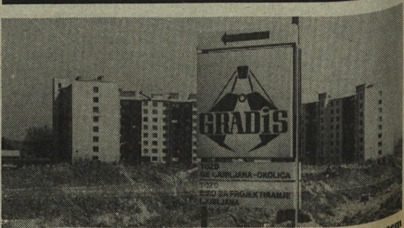
Tudi nova napisna plošča se bo kmalu morala umakniti gradbenim delavcem
