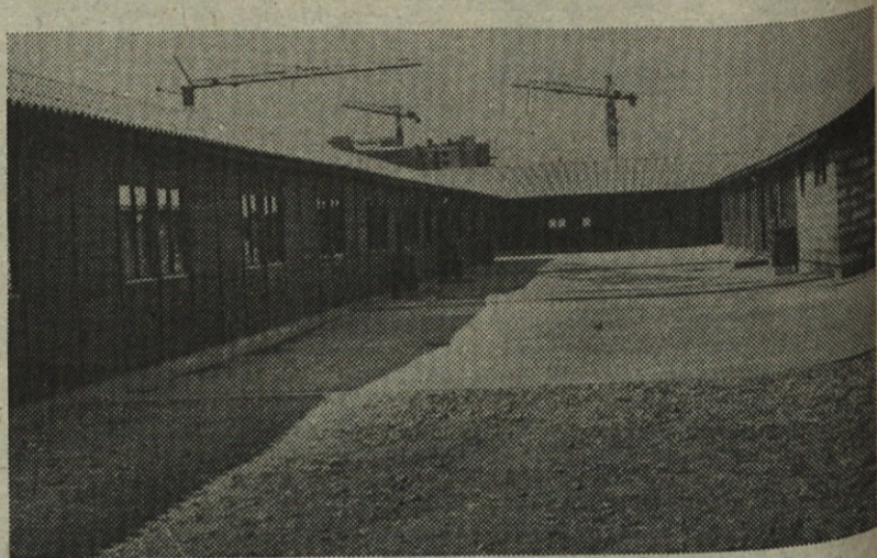
Obe novi baraki v Novih Jaršah bosta sprejeli 110 delavcev
