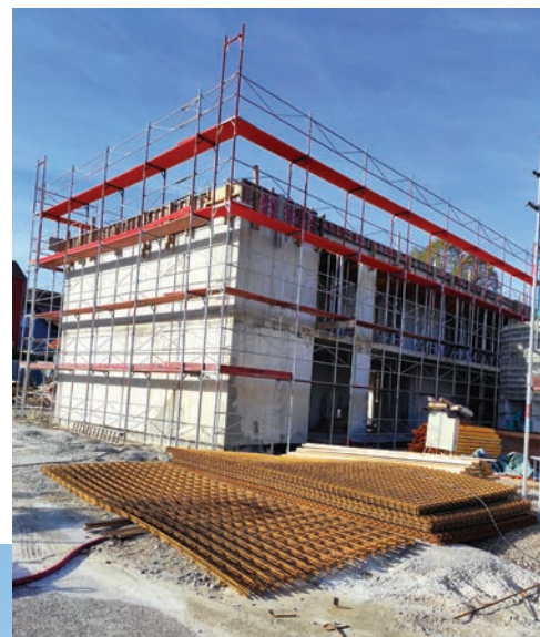
Gradnja napreduje v skladu s terminskim planom
