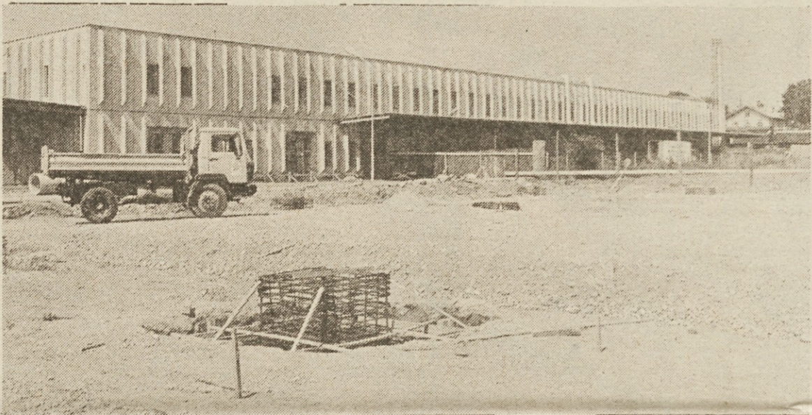
Najnovejši skladiščni objekt, na dvorišču pa že priprave za nadaljevanje gradnje.
