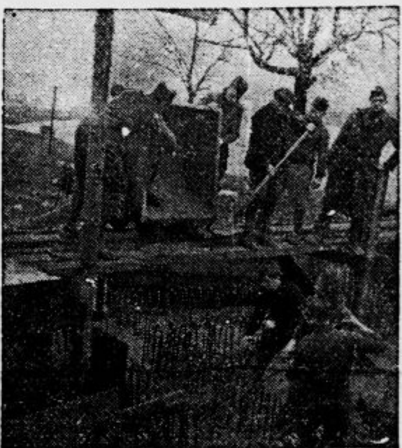
Betoniranje utrjene postojanke
