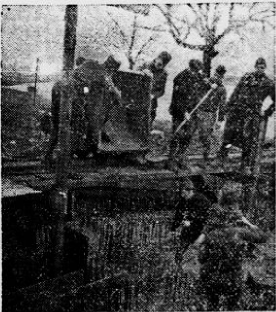
Betoniranje utrjene postojanke
