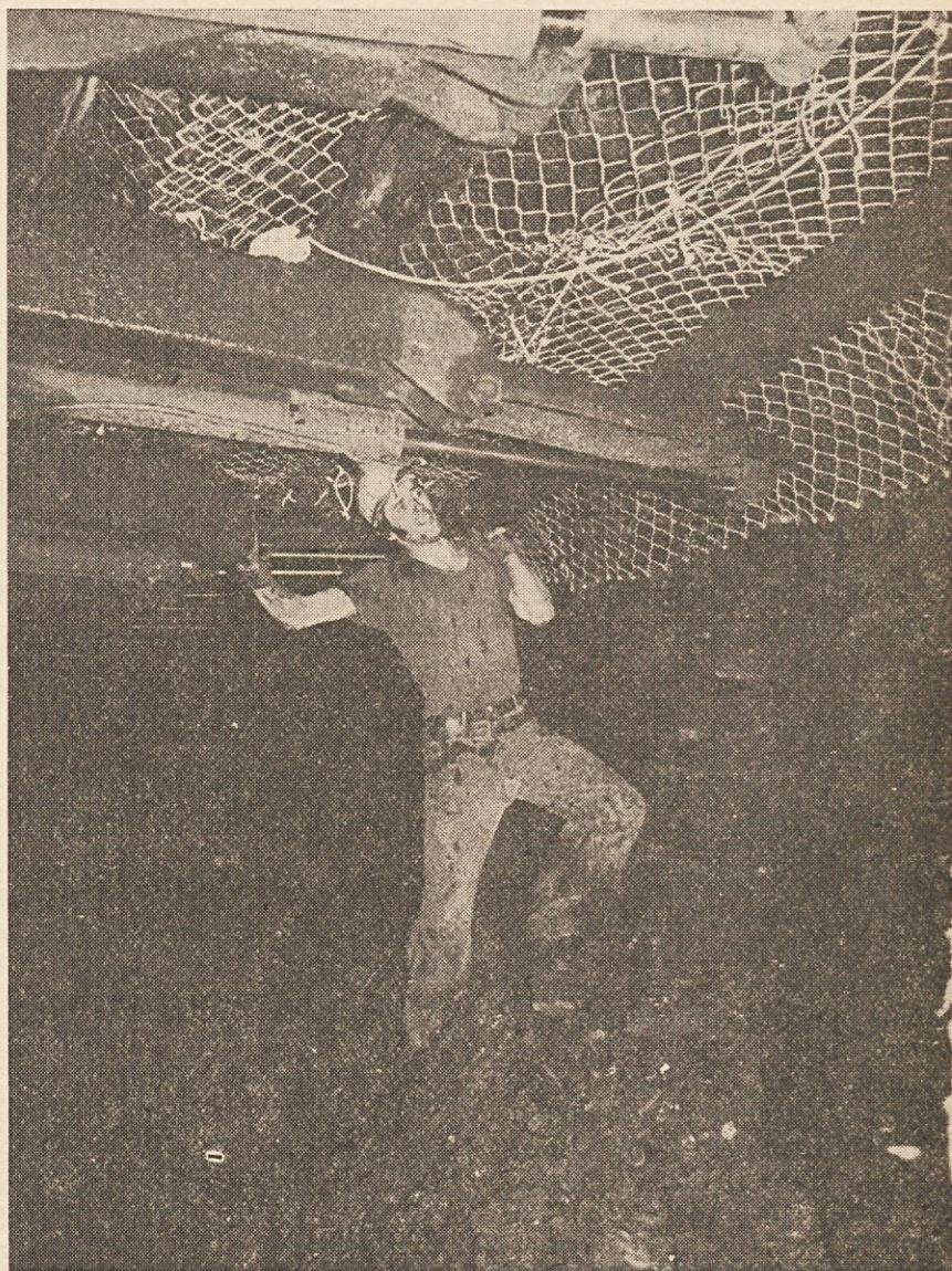
TOZD Premogovnik Trbovlje — na širokočelnem odkopu utrjujejo strop ob čelni fronti.
