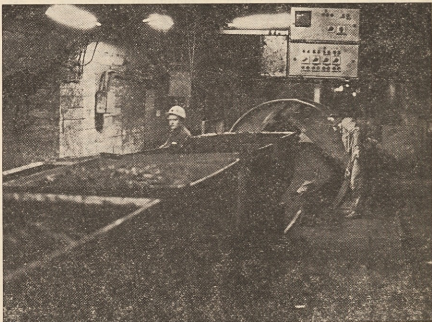
Pred separacijo premoga v Trbovljah je koncem zveznega rova zvrtačišče polnih vozičkov, naloženih z rovnim premogom.
