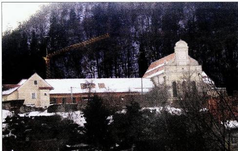
Pri obnovi skoraj 400 let stare stavbe celjskega kapucinskega samostana upoštevali nekdanji izgled in spomeniškovarstvene smerice.
