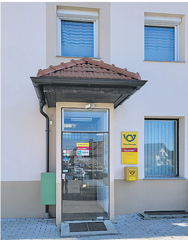
Pogodbena pošta 2383 Šmartno pri Slovenj Gradcu posluje v prostorih bivše pošte. Njihova osnovna dejavnost je zavarovalno zastopništvo.
