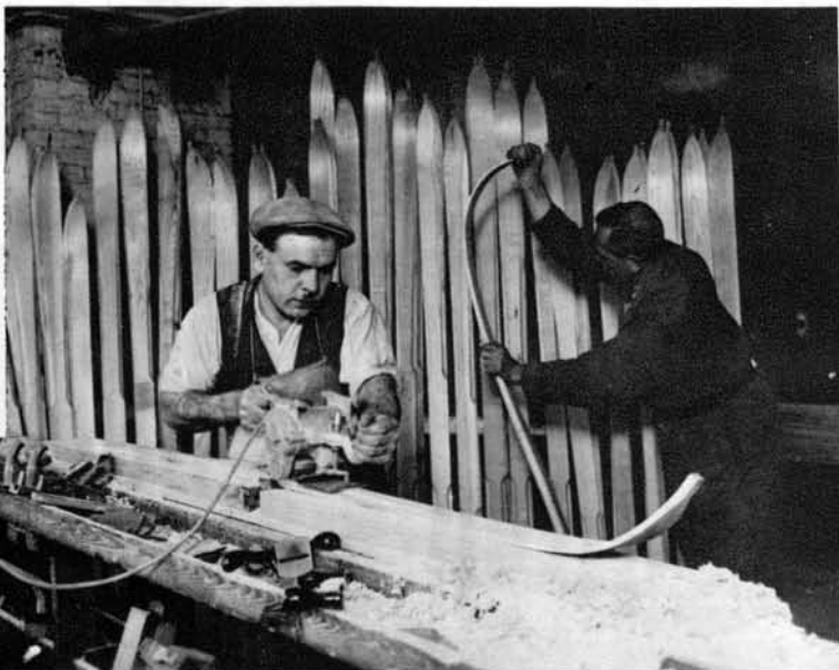
Oblanje smučk s posebnim električnim obličem.
