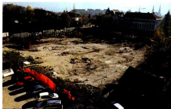
Gradbišče za Univerzitetno knjižnico Ljubljana kaže klavno podobo. Od konca devetdesetih let se dela niso premaknila z mrtve točke.
