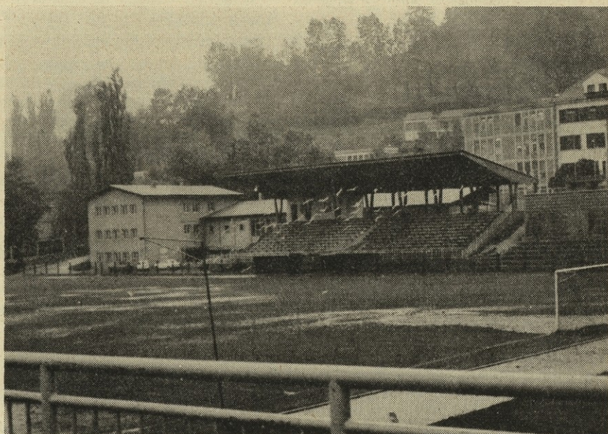
Dne 17. 6. letos je 63 rečnih galebov „zasedlo“ nogometno igrišče stadiona ŠD Rudarja v Trbovljah. Ob takratnih padavinah je bilo celotno nogometno igrišče skupno z atletsko stezo poplavljen. Od zadnje regulacije potoka Trboveljščice se voda ne odteka normalno, tako kot se je preje in bo potrebno prej ali slej izvesti sanacijo, da ne bi tudi v bodoče nastajalo občasno umetno jezero (foto: J. Drnovšek)
