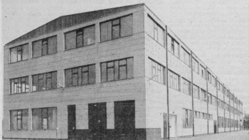
Nove proizvodne prostore Libele so zgradili po lastnem montažnem sistemu.
