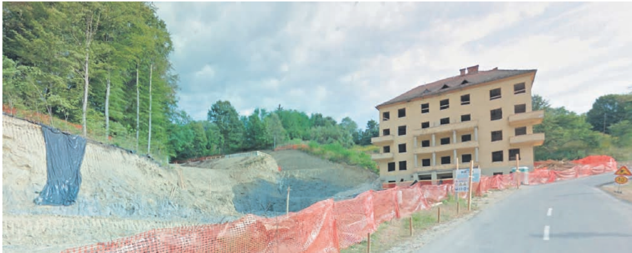
Gradbišče v bližini Aninega dvora, kjer naj bi v prihodnosti stal Atlantide Boutique Hotel. (Foto: TV)
