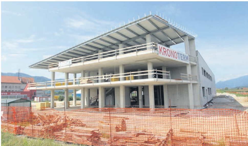
Kronoterm je proizvodne prostore v gospodarski coni v Trnavi začel graditi konec februarja. Ustanovitelj podjetja Rudija Kronovška žalosti, da v Sloveniji ni gradbenega podjetja, ki bi bilo sposobno zgraditi betonsko konstrukcijo. Braslovčani so morali najeti italijansko podjetje. To je bilo pri svojem delu izredno učinkovito, saj so po besedah Kronovška zaradi njihove učinkovitosti pridobili kar nekaj časa. Zdaj ko so dela prevzela slovenska podjetja, je naložba začela zaostajati za približno mesec, kar pomeni, da bo namesto decembra najverjetneje končana v začetku prihodnjega leta.
