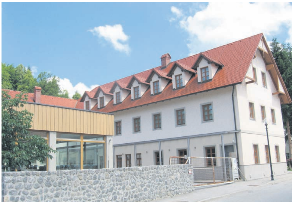
Tako izgleda novo gostišče Triglav. Starega so podrli do tal in zgradili novo stavbo, ki ima – ob upoštevanju napotkov službe spomeniškega varstva – isti tloris in isti zunanji videz. (Foto: B.J)
