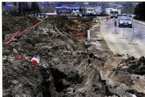
Ob cesti v Slovenskih Konjicah so delavci Gradkoma polagali cevi za meteorne vode.
