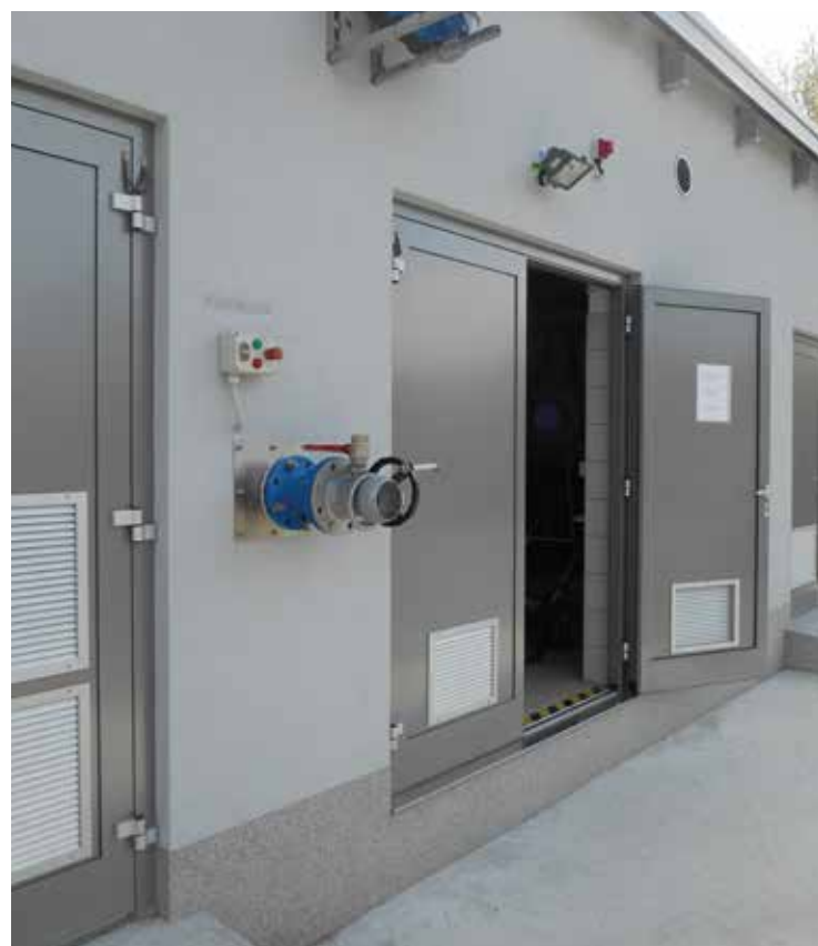
Priključek za cisterno za sprejem blata iz greznic
