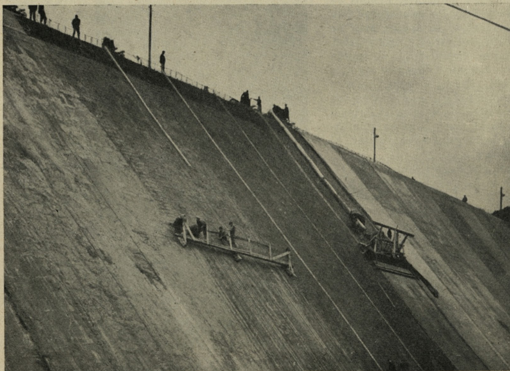
Sl. 3. Pogled na pregrado v Kokinem Brodu med izvajanjem tesnilnega sloja
