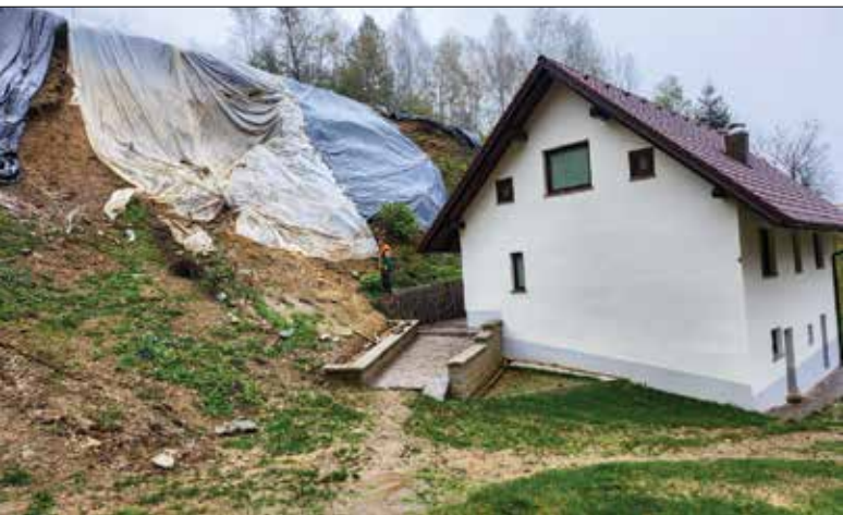
Zaščita plazu za stanovanjskim objektom v Občini Gornji Grad, Mačkin kot (foto: arhiv Občine Gornji Grad)
