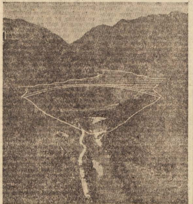
Več kot sto metrov visoka ločna pregrada bo pri Tribuški zagradila Idrjico pet in zagotovila milijone kilovatih ur na leto.
