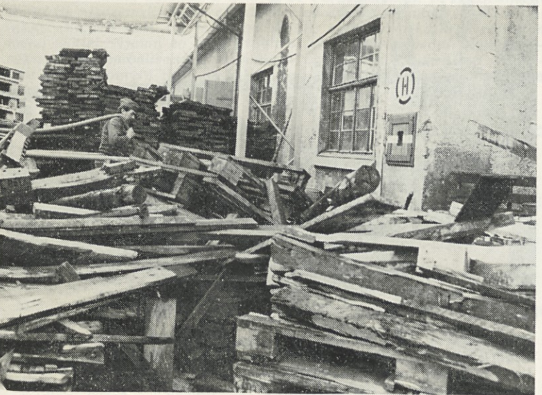
Prava plezalna veščina je potrebna, da se pred embalažno delavnico dokoplješ do hidranta
