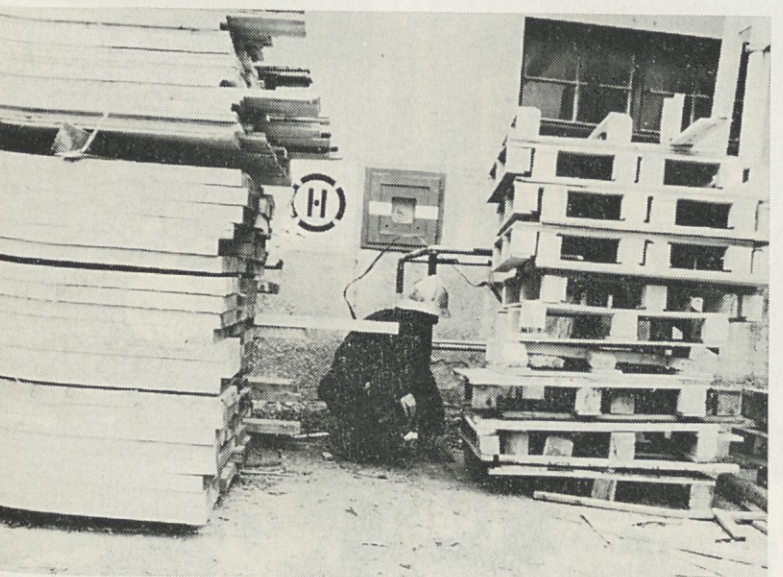
Tudi ta hidrant ni dostopen; na njem so naložene palete, ograja, ki bi ga morala takšne »obremenitve« ščititi, pa je lepo prestavljena. In koliko več škode bi v primeru zaresnega požara zaradi takšnega neodgovornega obnašanja bilo? Ali so se tisti, ki so za te stvari odgovorni, že kdaj to vprašali?
