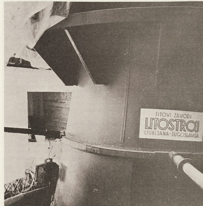
Montaža in kontrola montaže turbinskega stola druge turbine v Mavčičah. Turbinski stol je postavljen na turbinskem pokrovu; stol nosi nosilni ležaj in s tem celoten rotor agregata.
