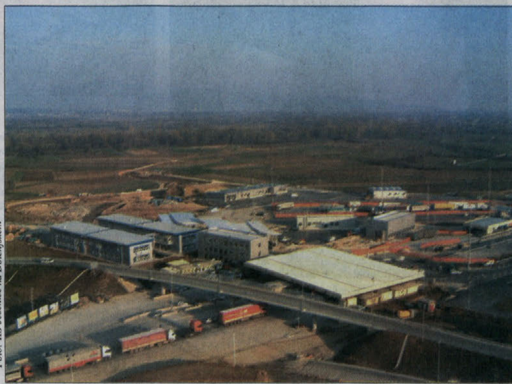
Obrežje: za novim nadvozom levo dva identična objekta GTO, vmes carinsko poslopje, nato stara kontrolna ploščad, ki jo bodo porušili. Zadaj sta objekta fito in veterinarske inšpekcije, na sredini so objekti za podroben pregled vozil in pomožni objekti.
