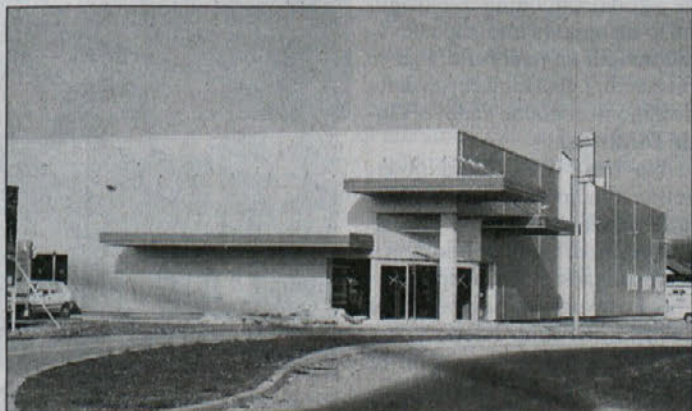
Supermarket Tuš v gradnji
