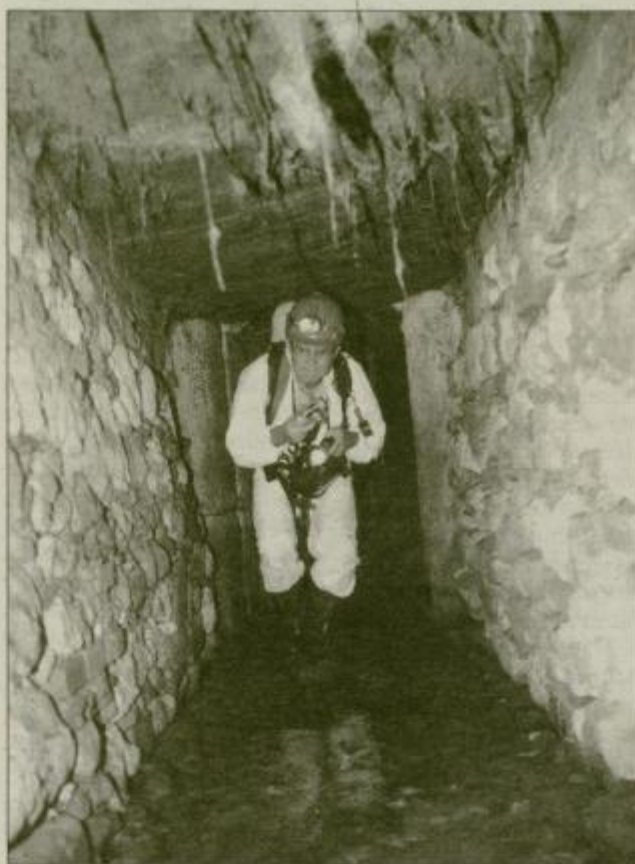
Rimska kanalizacija od znotraj in naš vodnik Vojko Dobovičnik, vodja vzdrževanja kanalizacijskega omrežja.
