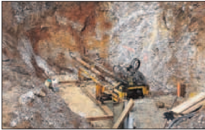
Tehnično zahtevni preboj pod železnico na Lazih. (foto: IT)
