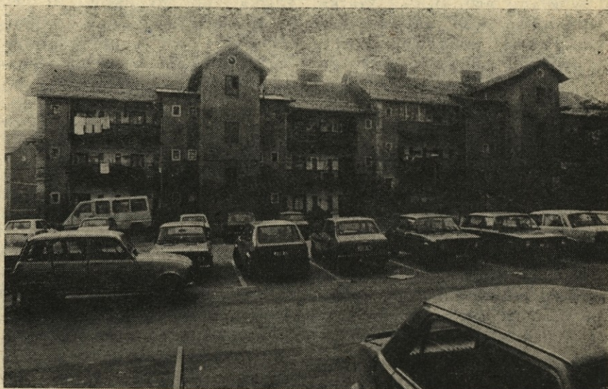
Zadnji del rudniških stanovanjskih blokov na Njivi — Trg svobode, se je s porušitvijo starih drvarnic in kleti odprl. V neposredni sosesčini na desni strani stojita dve novi stanovanjski stolpnici.
