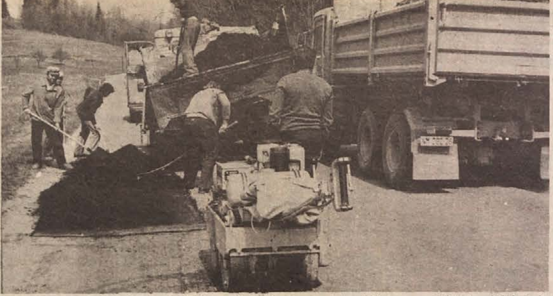
GORJANSKO CESTO POPRAVLJAJO – Prejšnji teden so delavci Cestnega podjetja krpali luknje in ponekod kar globoke jame, ki so se vgnezdile na cesti od Metlike do Suhorja. Ker je ta cesta precej prometna, jamam pa se je nevarno izogibati, bo popravilo nedvomno pripomoglo k večji varnosti v prometu. (Foto: R. Bačer)
