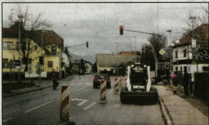
Križišče bo po gradnji glavne ceste bistveno drugačno. Fotografija je bila posneta ob gradnji plinifikacije.
