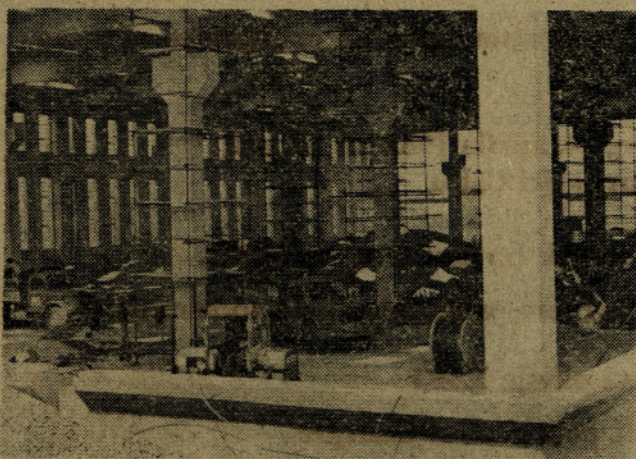
že na začetku so se pojavile določene težave zaradi nosilnosti tal, kar je zahtevalo dodatna dela. Težave so se pojavljale tudi pri nadaljnjem delu, nastale pa so tudi številne podražitve pri gradnji in pri nabavi opreme.
