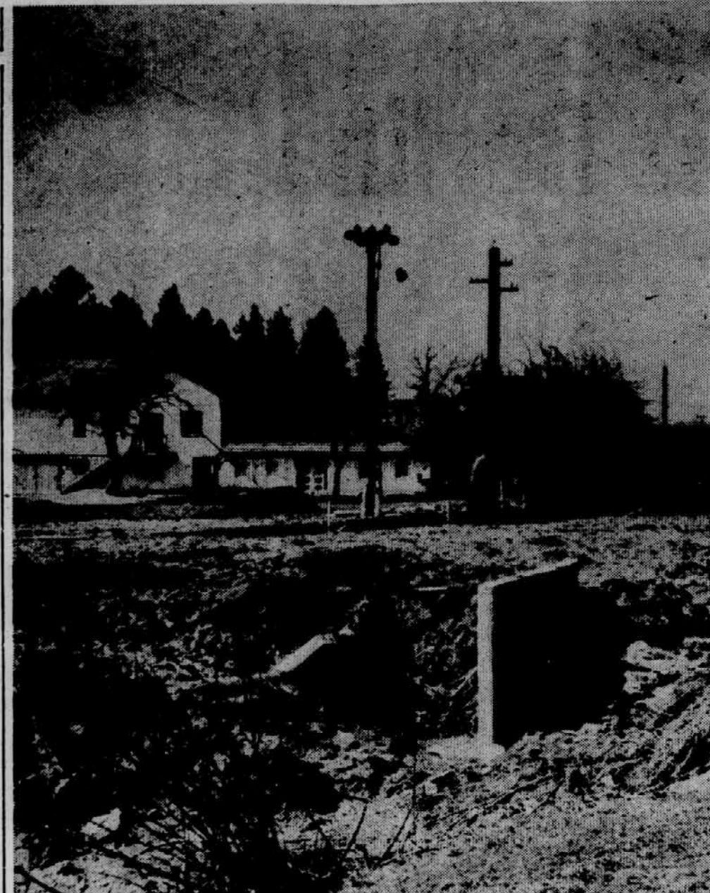
V DOBROVI PRI CELJU POGRESAJO MOST - Tu, kjer štrlijo v zrak betonski nosilci, je bil nekot most. Pa so ga lansk jesen ob regulacijskih delih Koprivnice porušili. Nekaj metrov stran je nastalo novo korito, tudi nasip ob njem urejajo, toda mostu ni več. In prav tega tamonjši ljudje na robu Celja močno pogrešajo. Gre namreč za masivno prekinitvev močno zasedene ceste, ki pelje skozi Dobrovo v Lokrovec. Domačini bi bili veseli, če bi postavili vsaj ozko brv za pešce in kolesarje. Foto: M. Božič
